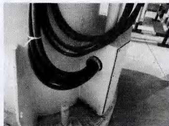
图 2 立柱钻孔铺设电缆到主电柜
